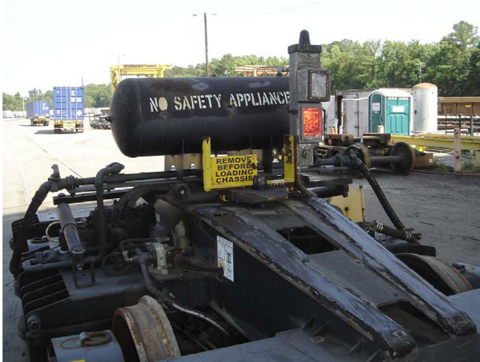
Figura 47 Mordaza DET y dispositivo DET instalados en la unidad intermedia posterior/de empuje
